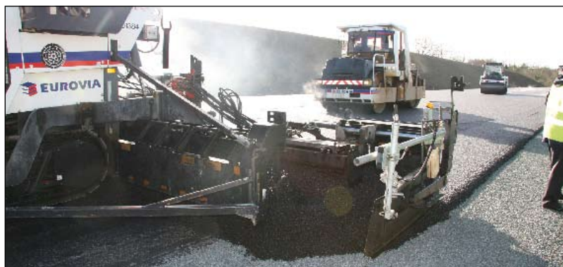
La pose du bitume se fait sur un sol propre et sec.
