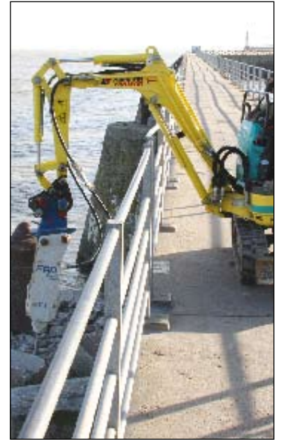
Les travaux de la passerelle Saint Nicolas viennent de commencer, la première partie consiste en la démolition des 17 travées.
