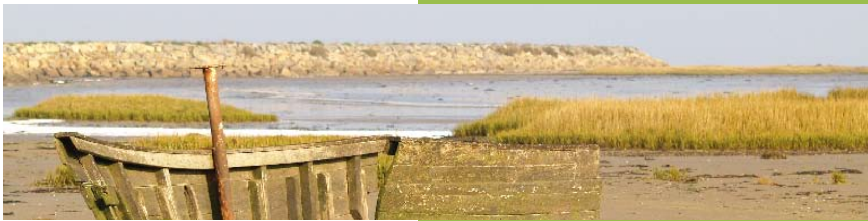
De nombreux perrés et digues, comme ici à Noirmoutier, ont été confortés sur le littoral vendéen.
