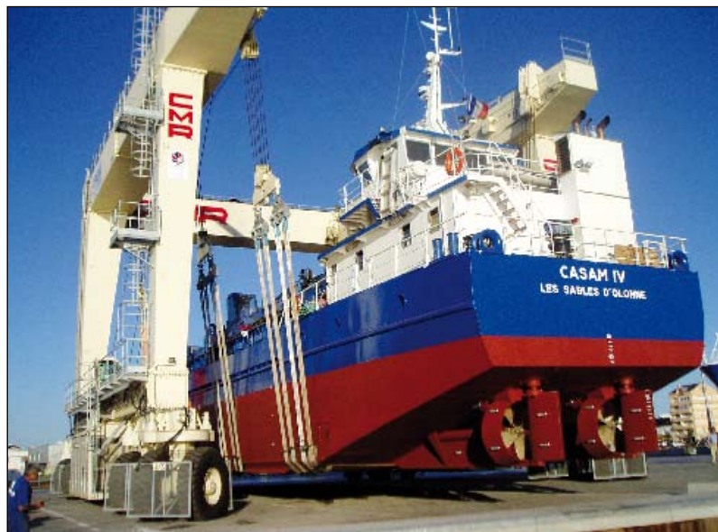
L'élévateur du terre-plein de la Cabaude est capable de soulever des bateaux de 500 tonnes.
