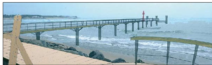
Dans un premier temps, les piles de l'estacade ont été démolies avant d'être reconstruites avec des matériaux plus appropriés aux attaques du vent et de la mer.
