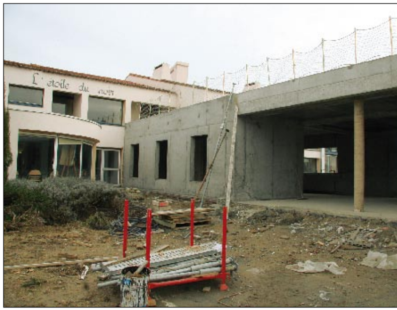
Les travaux entrepris à L'Étoile du soir permettront d'accueillir les malades d'Alzheimer
