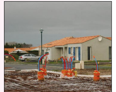
Lotissement en construction à Notre-Dame-de-Riez, la petite commune continue d'attirer de nouveaux habitants.
