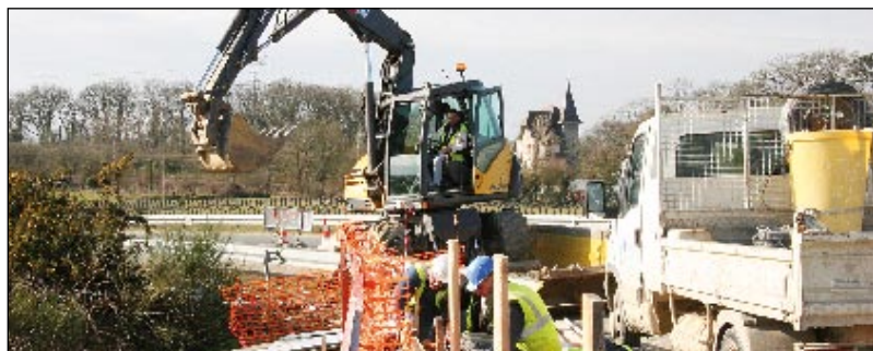
L'agglomération de Belleville-sur-Vie va être libérée de la circulation.
