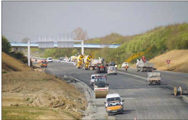
Les retards du chantier ont été plus que largement rattrapés.
