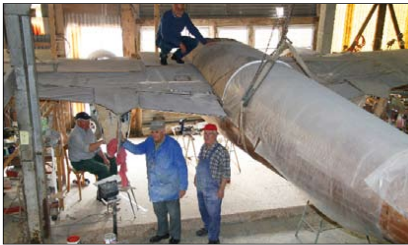
Dans un an, le Mosquito de Luçon volera dans le ciel vendéen. Près de quinze ans auront été nécessaires à sa construction.
