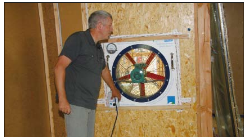
Jacky Guérin, président d'ACV Maisons Bois, met en marche le ventilateur pour tester l'étanchéité à l'air d'une maison
