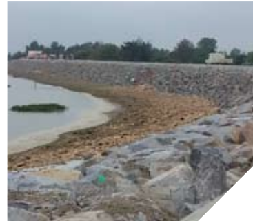
Depuis quelques mois, les travaux des digues se sont accélérés en Vendée.
