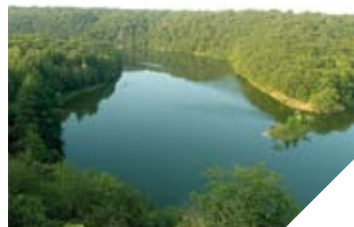
La nouvelle usine de la Balingue, située à Mervent, permet à la Vendée de consolider son approvisionnement en eau.
