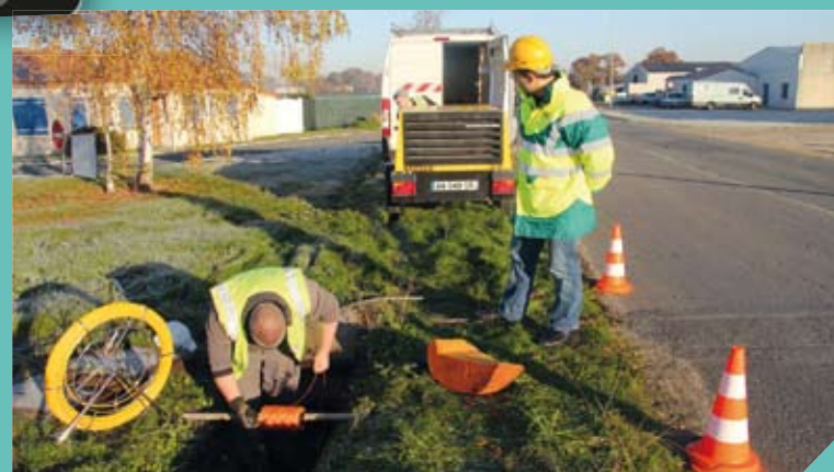
Entre Belleville-sur-Vie et Saligny, les techniciens vérifient l'état des fourreaux.
