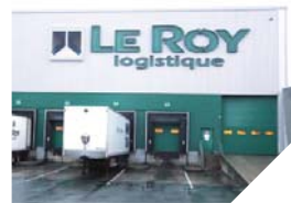
Le Roy Logistique construit un nouvel entrepôt en face de son site actuel aux Herbiers.
