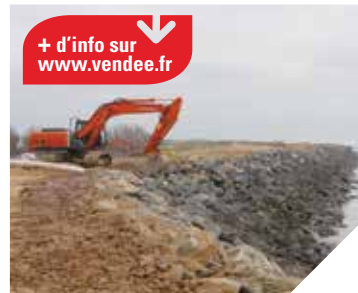
L'instruction adressée aux Préfets devrait accélérer et simplifier les procédures pour effectuer les travaux sur les digues.
