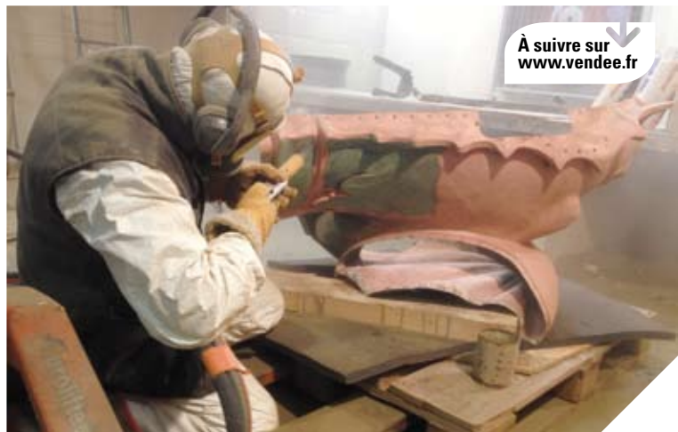
Le microgommage permet de retirer l'oxydation qui se trouve sur la partie cuivrée.
