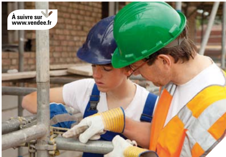
Les jeunes du parcours de la seconde chance ont commencé leurs cours et stages en entreprise.
