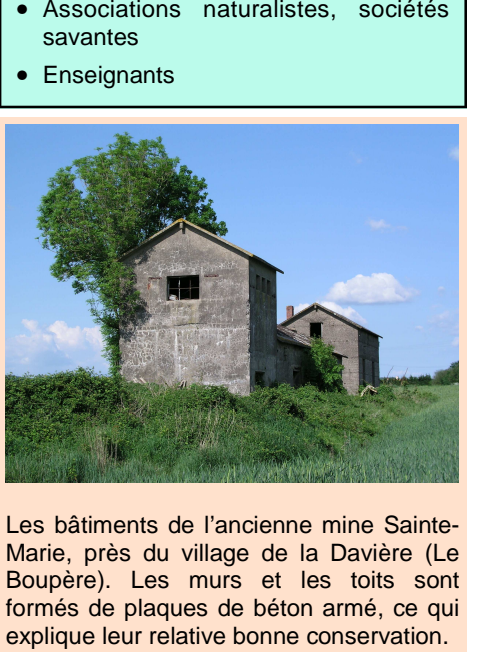
Les bâtiments de l'ancienne mine Saint-Marie, près du village de la Davière (Le Boupère). Les murs et les toits sont formés de plaques de béton armé, ce qui explique leur relative bonne conservation.
